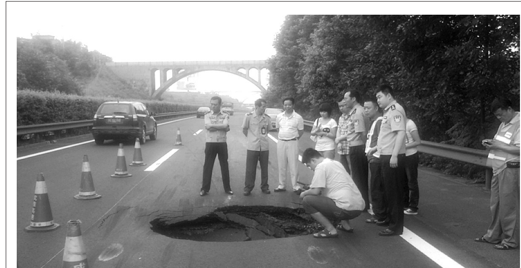
高速交警正在路面塌陷处设置提示标志
