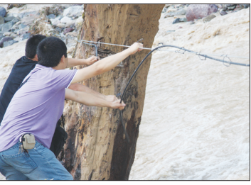
洪水当前电信员工抢修光缆
