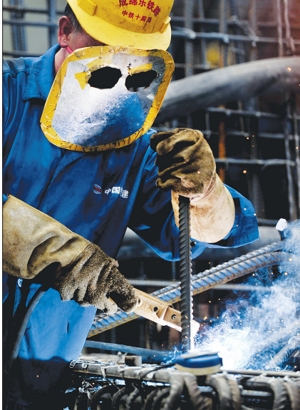
焊接桥梁钢架的工人每天要穿厚重的防护装备
