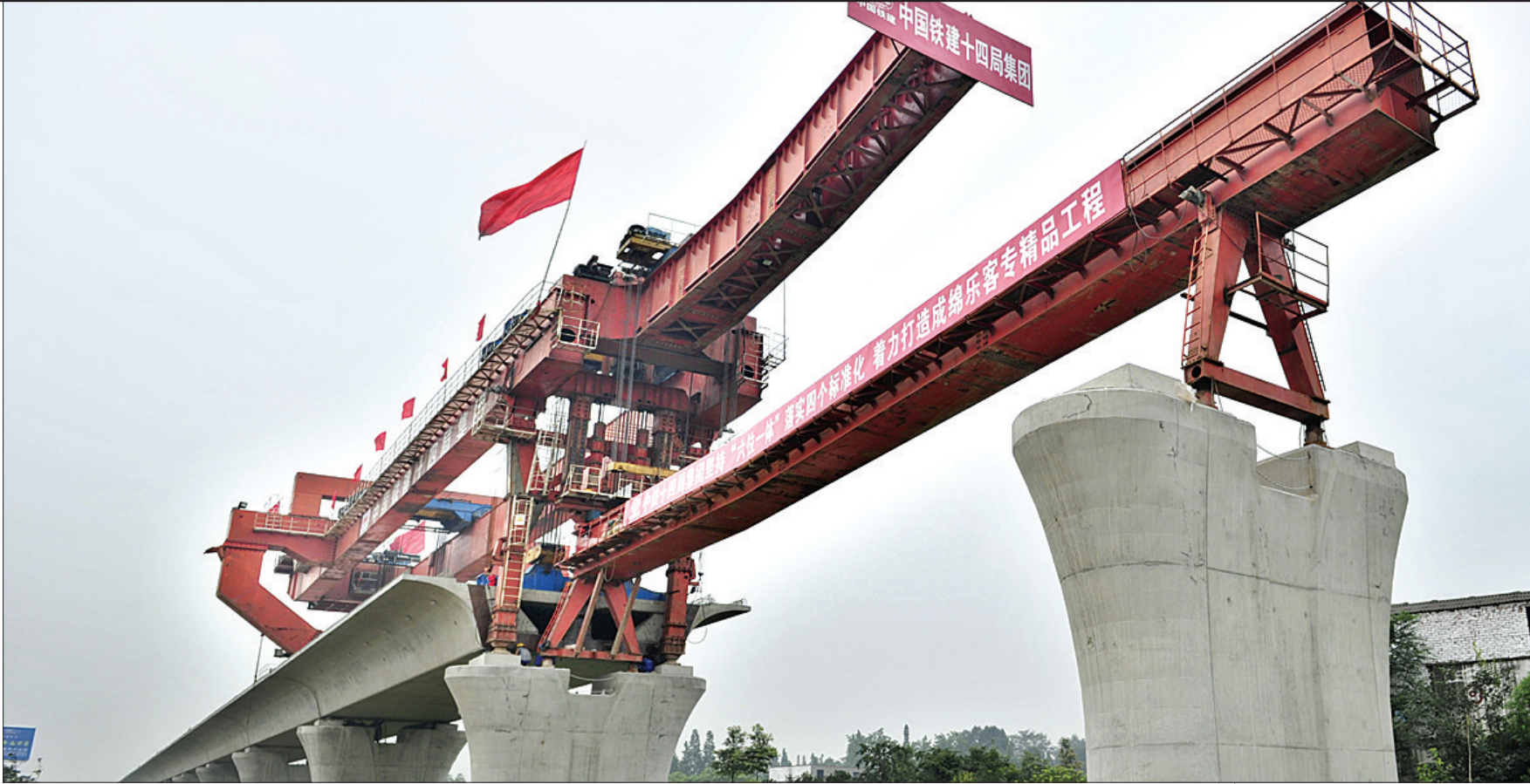
一片片巨梁被安装在预制好的桥墩上,如同巨龙贴地潜行
