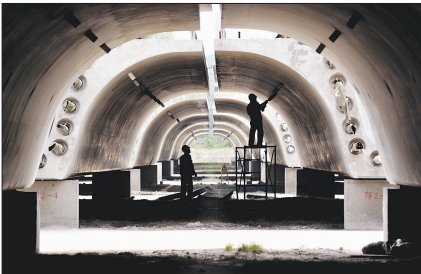
巨梁安装前工人在进行最后的详细检查
