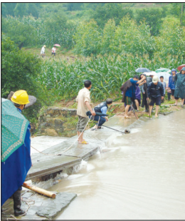
水库排险现场
